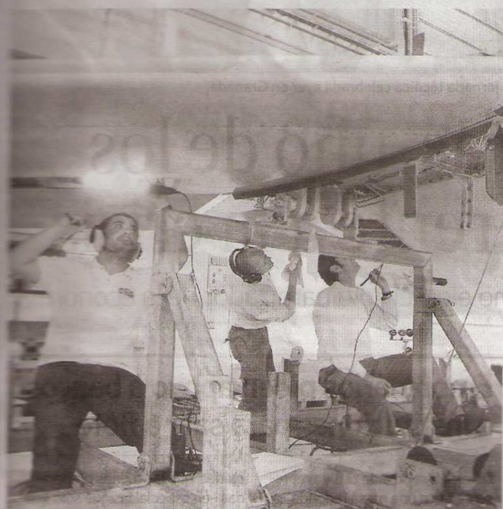
La construcción aeronáutica evita un desplome exterior mayor.
